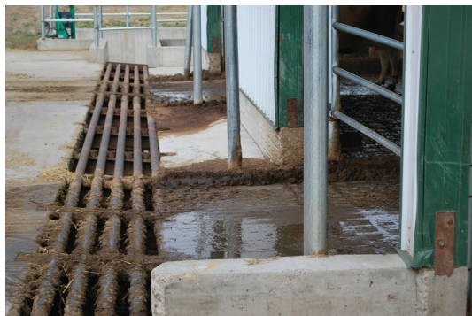
Figura 10.20 Ky është një shembull i kanalit të ndërthurur. Fotografia: Lean Farming
